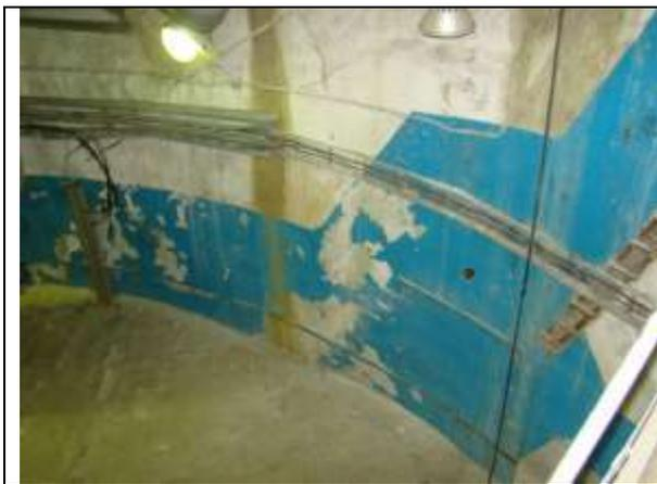
Стены машинного зала имеют физический износ
