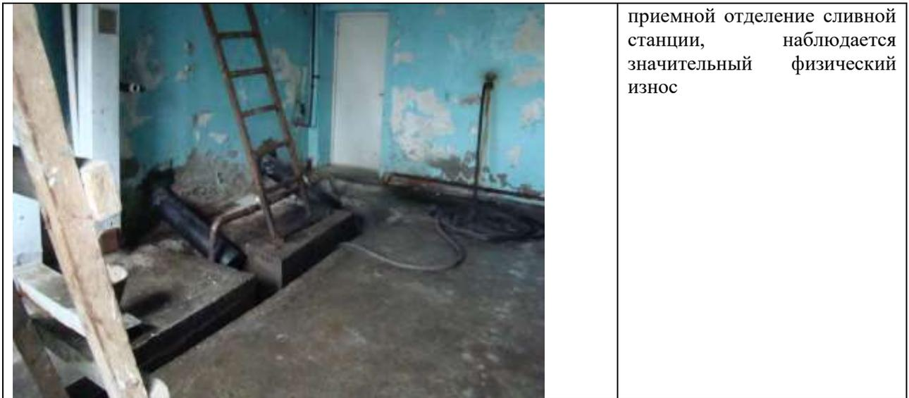
приемной отделение сливной станции, наблюдается значительный физический износ
