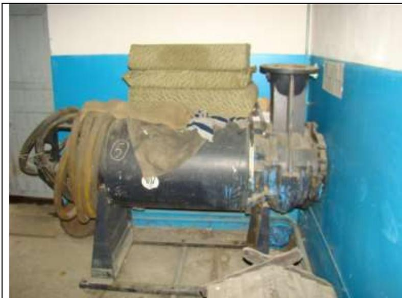
Насос Grundfos выведенный из эксплуатации в связи с регулярными неисправностями. Установленные в 2013 году насосы Grundfos проявили неспособность к безаварийной работе в агрессивной среде (перекачка сточных вод)
