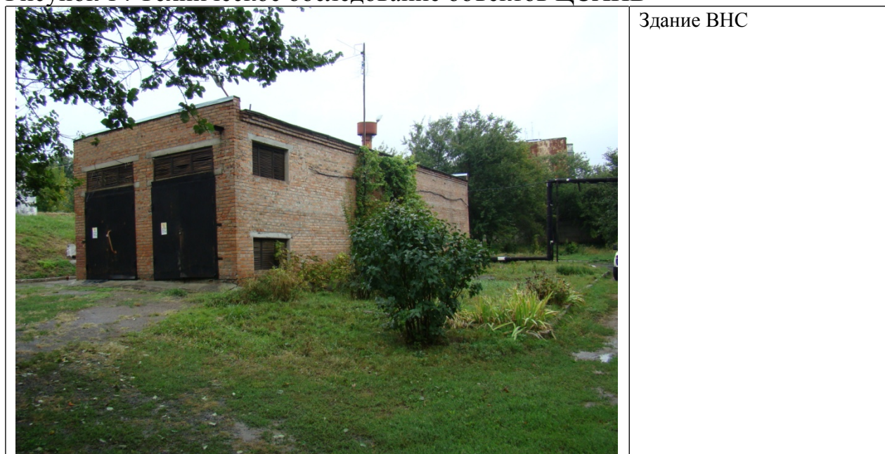
Рисунок 14 Техническое обследование объектов ЦСХПВ
