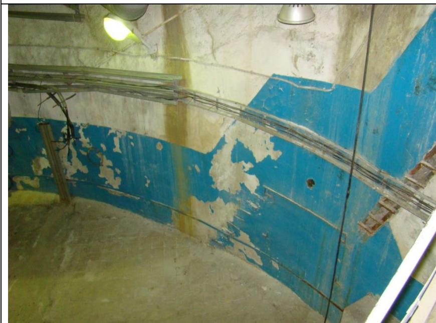
Рис. 12 – Стены машинного зала имеют физический износ
