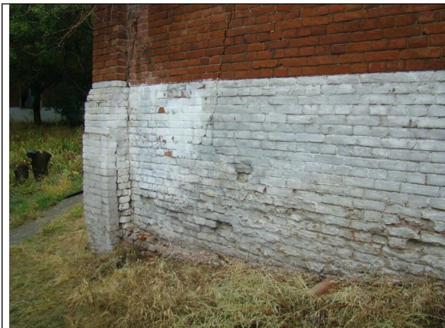
Рис. 4 – 7 – Здание хлораторной находится в аварийном состоянии, наблюдаются трещины и разрушения кирпичной кладки
