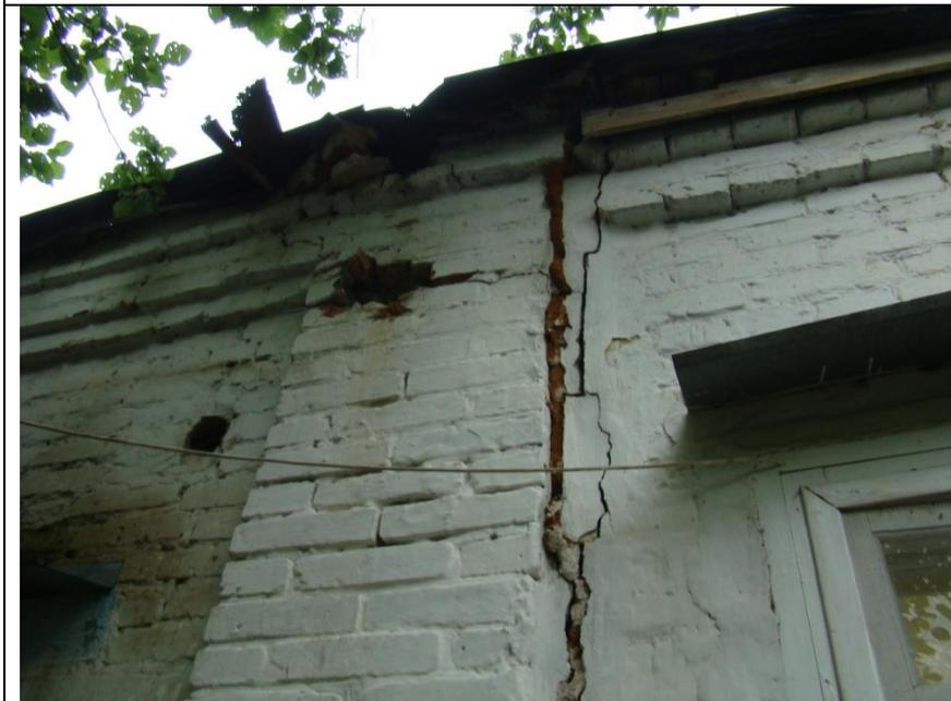
Рис. 2 – 4 – Здание ВНС. Наблюдаются трещины, физический износ
