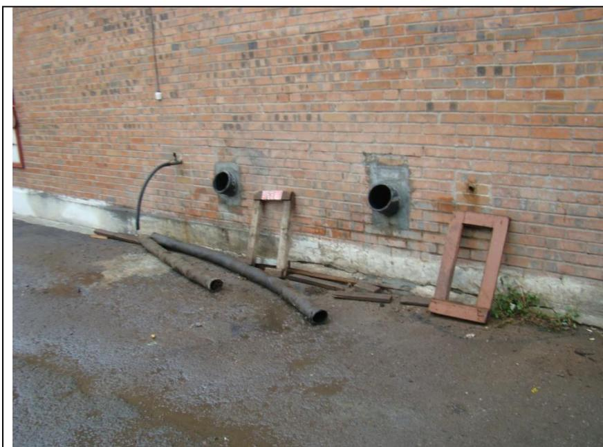
Рис. 9 – Отверстия для приема подвозимых сточных вод
