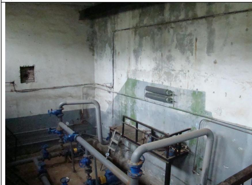
Рис. 11 – В связи с заглублением зала размещения насосных агрегатов и физическим износом, здание ВНС имеет физический износ, обусловленный подтоплением дождевыми и тальными водами
