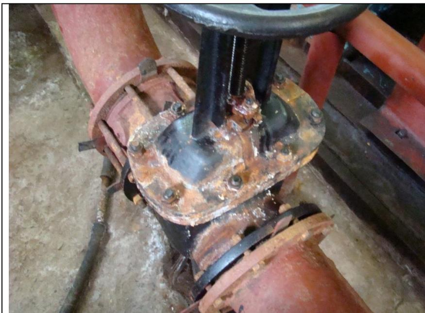
Рис. 22 – Коррозия запорной арматуры
