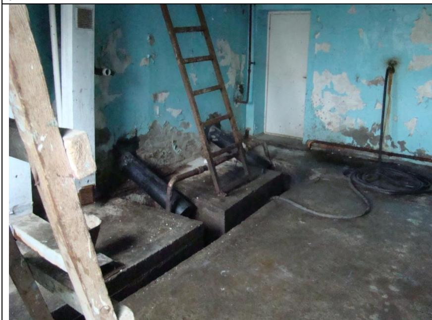
Рис. 10, 11 – приемной отделение сливной станции, наблюдается значительный физический износ
