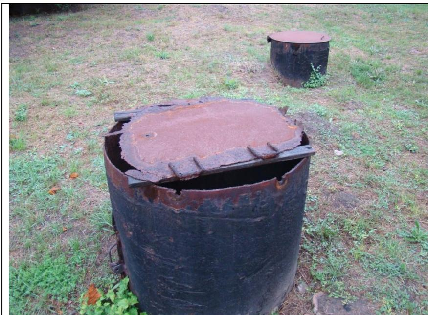
Рис. 12, 13 – Смотровой колодец приемных резервуаров. Наблюдаются интенсивные коррозионные процессы
