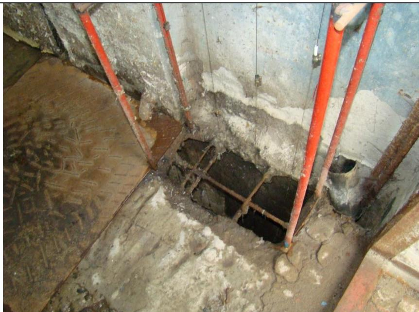
Рис. 5, 6 – Приемной отделение КНС. Наблюдается значительный физический износ
