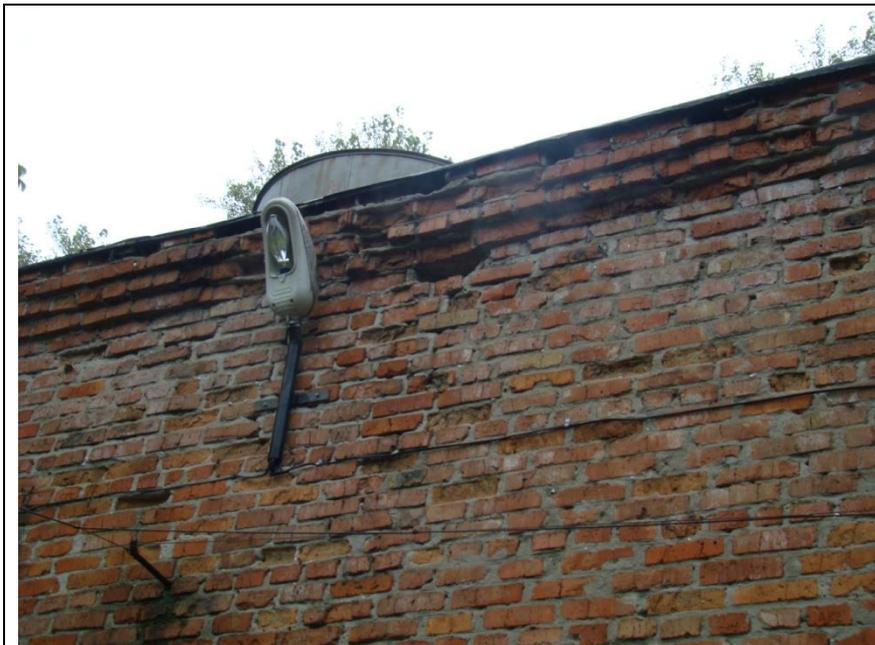
Рис. 7-8 – Разрушение кирпичной кладки
