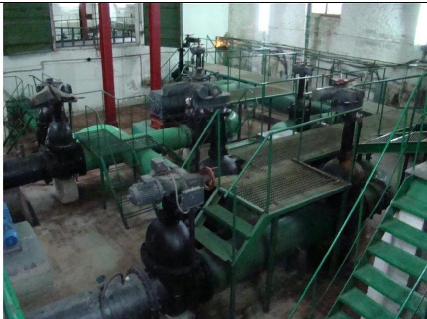
Рис. 10 – 15 – зал размещения насосов 1Д630-90А № 4 и № 5
