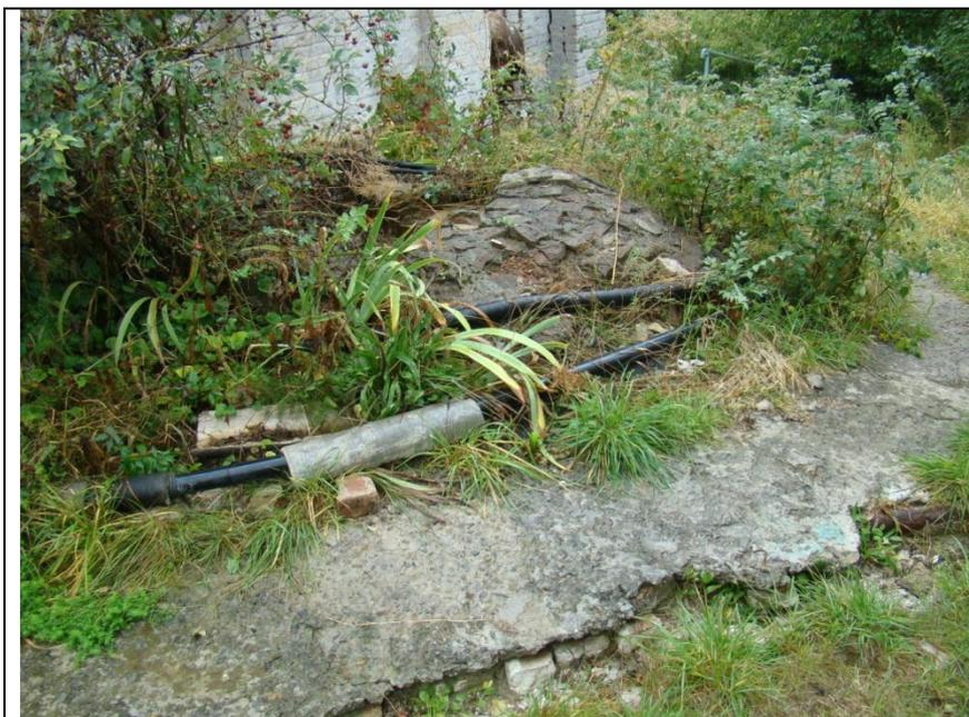
Рис. 8 – Хлоропровод от здания хлораторной до врезки в водопровод
