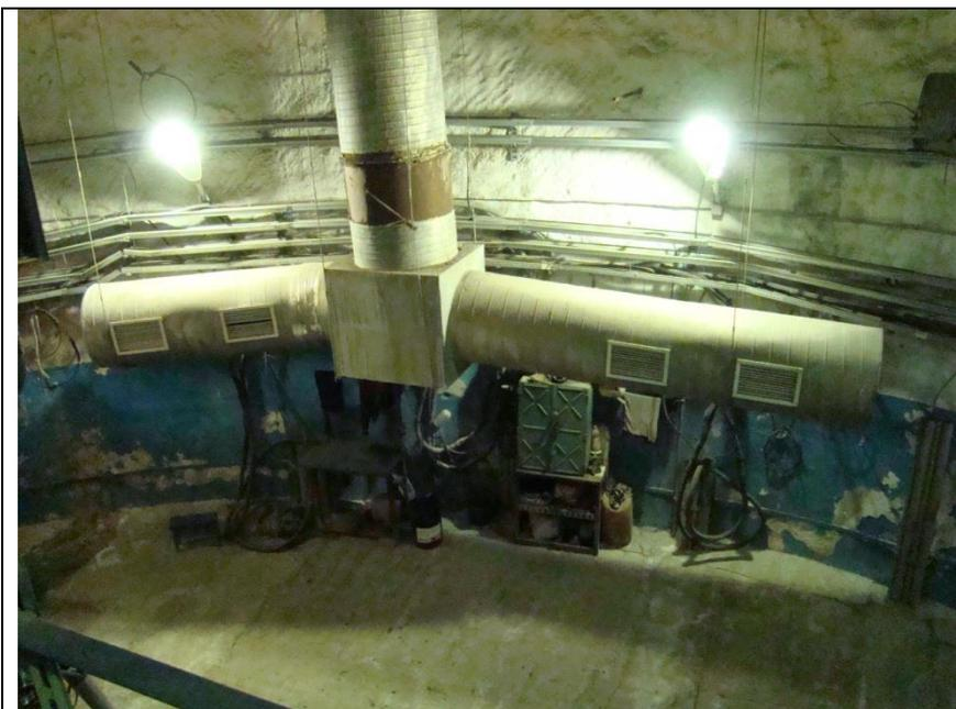
Рис. 11 – Вентиляция в машинном зале
